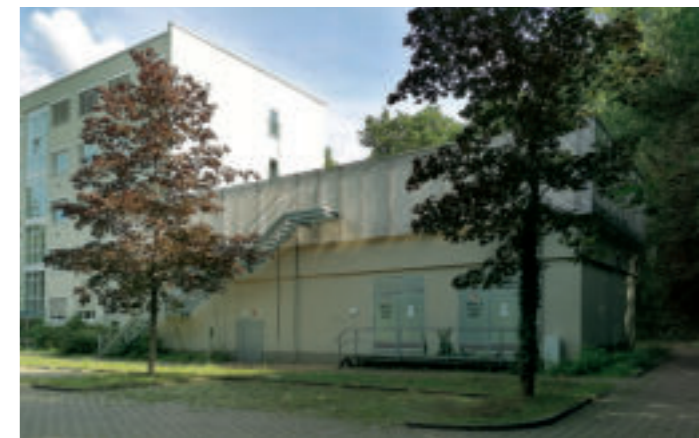
Außenansicht des ehemaligen Trafo-Gebäudes.
