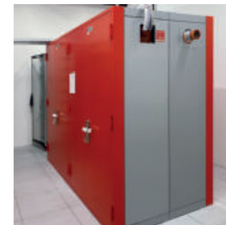
Die modularen DC IT Safes können beliebig erweitert werden.
